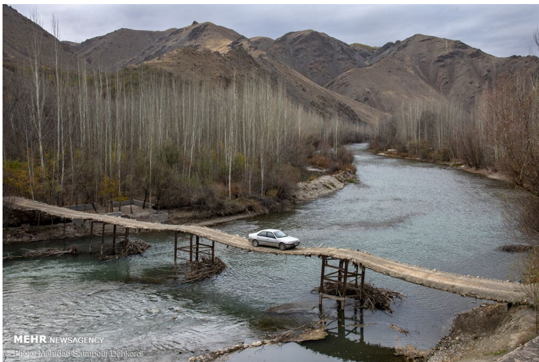
پل چوبی مارکده (پل گبز) - شهرستان سامان
